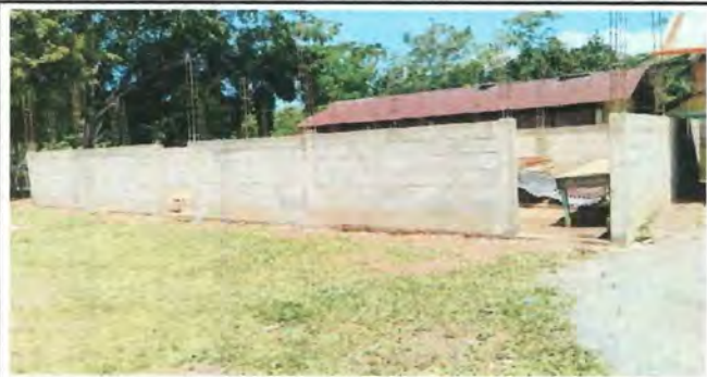
Foto 1: La estructura del centro educativo de telesecundaria cuenta con un módulo de dos aulas, las cuales requieren del mejoramiento de los muros de mampostería.
