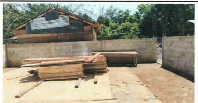
Foto 5: Se requiere el mejoramiento de mochetas y columnas del módulo de aulas.
